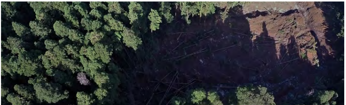
Figura 11: Deslizamento de terras
