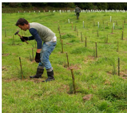
Figura 20: Marcação e piquetagem
