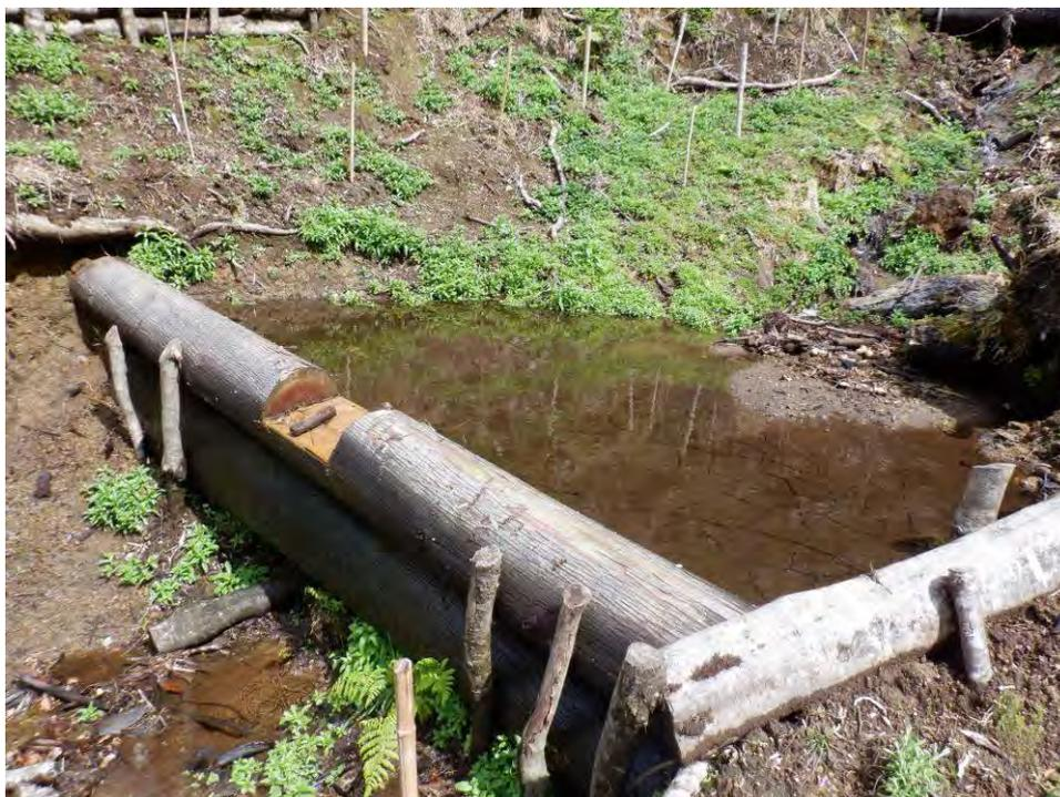
**Figura 11.** Dique construído com material autóctone em uma das linhas de água de regime torrencial na bacia hidrográfica da Mata dos Bispos.
