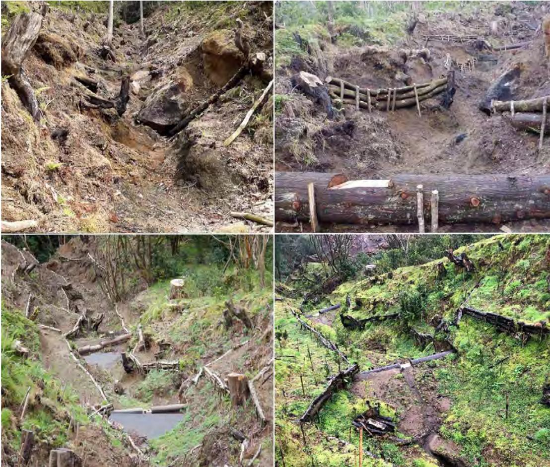
**Figura 12.** Intervenção da linha de água em quatro diferentes etapas 1: após controlo de EEI (acima, à esquerda); 2: Início da instalação das estruturas de engenharia natural no leito e nas margens (acima, à direita); 3: margens e leito da linha de água estabilizadas através de diques e degraus vivos (abaixo, à esquerda); 4: linha de água com margens plantadas.
